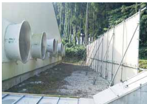
除塵布の設置
