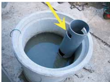
水張り豚舎での例
