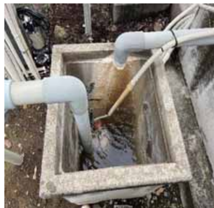
写真 4 水洗脱臭に使用した水の廃棄 (脱臭槽の地下水は、オーバーフロー分を場外に排水)
