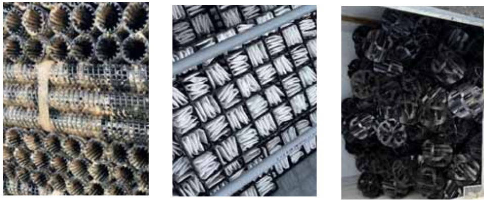
写真2 設置した濾材の様子 (①筒状の接触濾材、②活性炭を不織布に充填した接触濾材、③球状の接触濾材)
