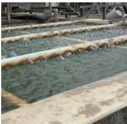
写真 3 縦コン排気を水と接触している様子 (地下水を常時流入させる)
