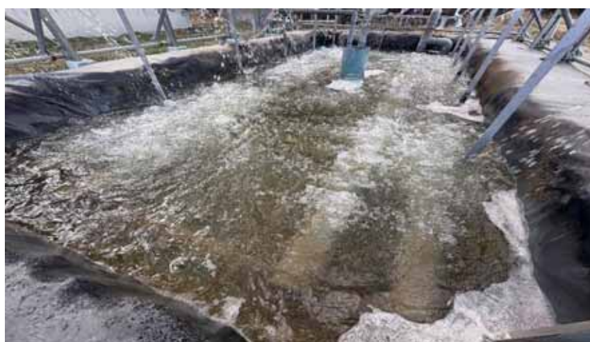
写真4 堆肥舎排気を水洗脱臭装置で曝気している様子
