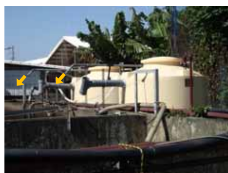
写真 4 臭気捕集タンクの排気側
