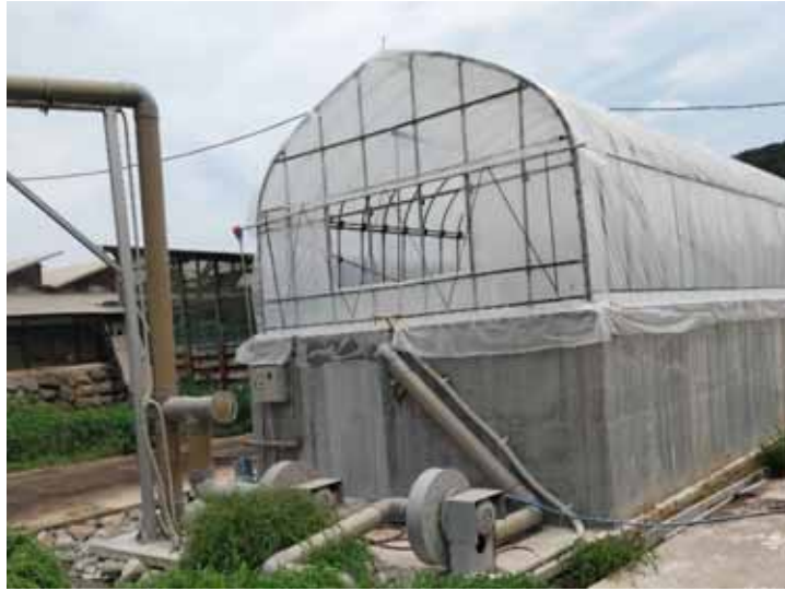
写真2 軽石脱臭槽外観
