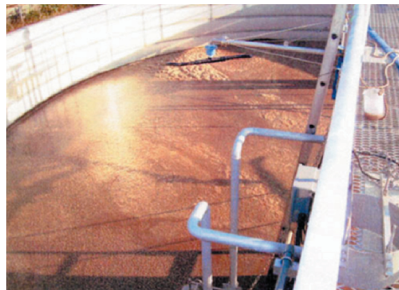
ばっ気槽内部
