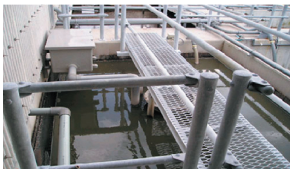
第一沈殿槽
