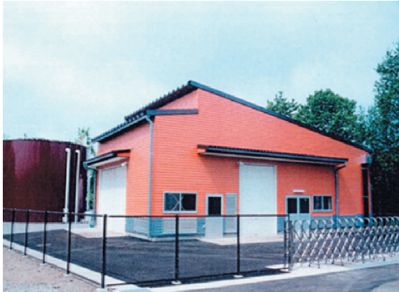
施設全景（機械棟と発酵槽）
