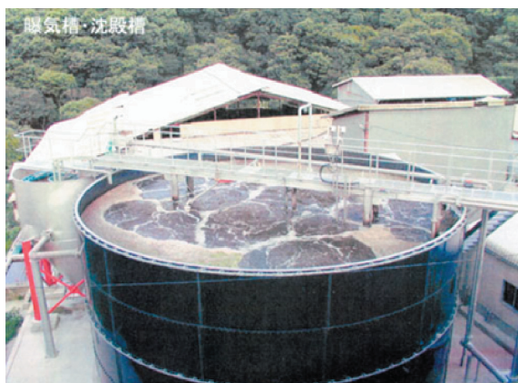
ばっ気槽、沈殿槽
