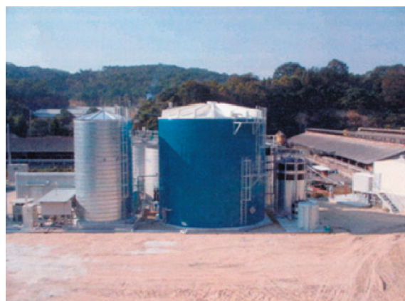
メタン発酵槽 (3)
