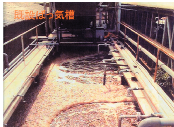
既設ばっ気槽
