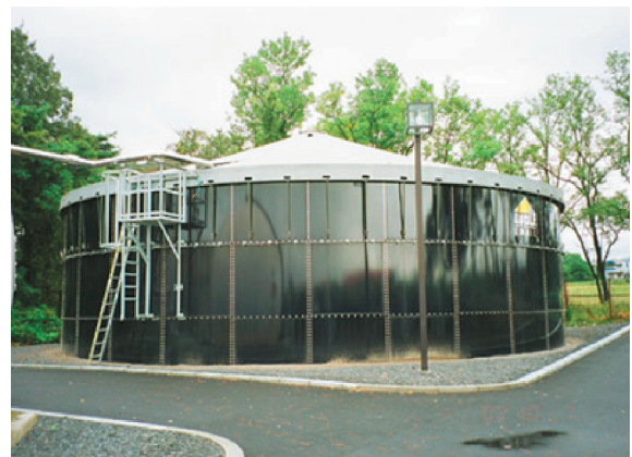
消化液貯留槽
