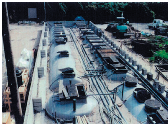
配管、電気据え付け状況
