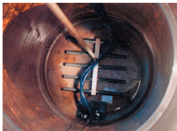
ばっ気槽内部
