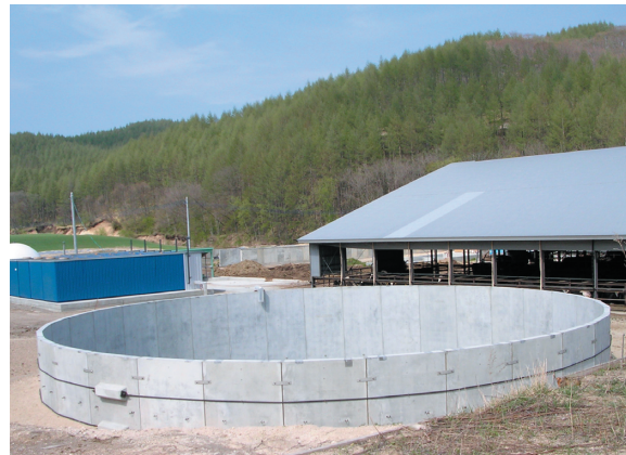
消化液貯留槽
