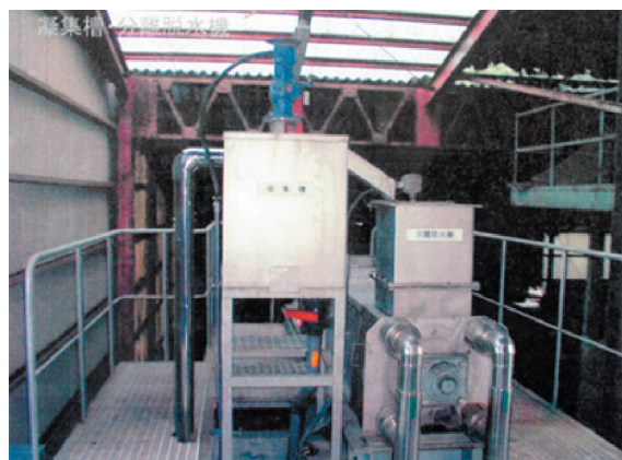
凝集槽、分離脱水機
