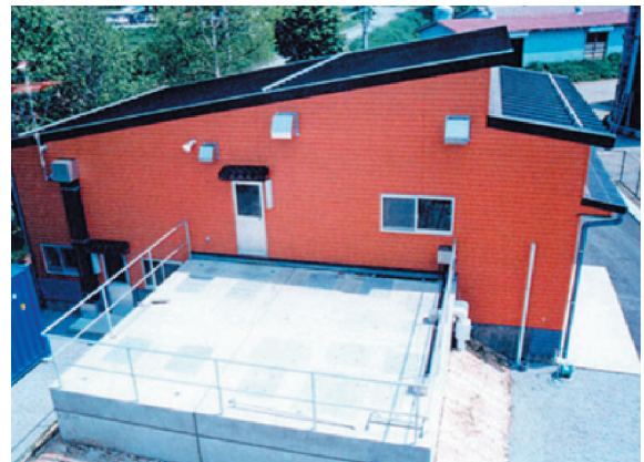
施設全景（消化液浄化設備と機械棟）
