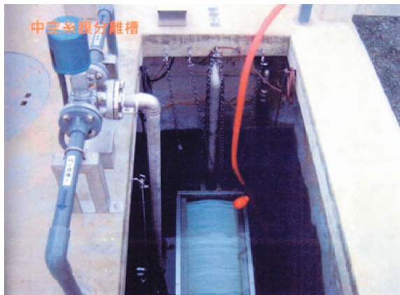
中空糸膜分離槽 (設置状況)
