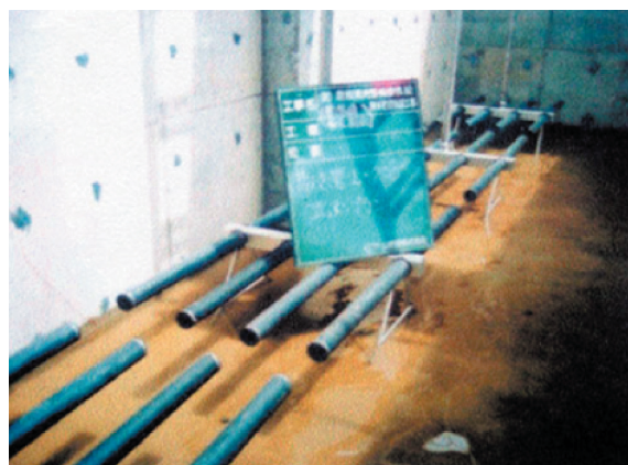
ばっ気槽下部散気管
