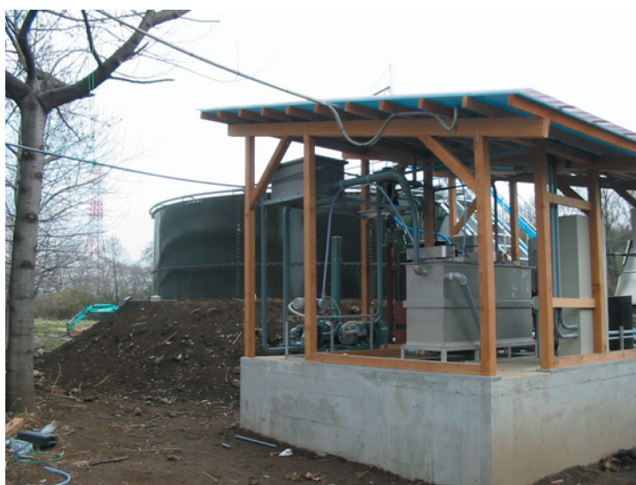
固液分離機建屋(手前) 円形バッキ槽(左奥)
