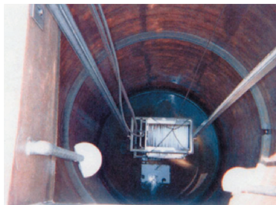
膜分離槽・膜ユニット設置状況
