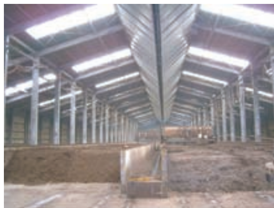
ロータリー式発酵槽
