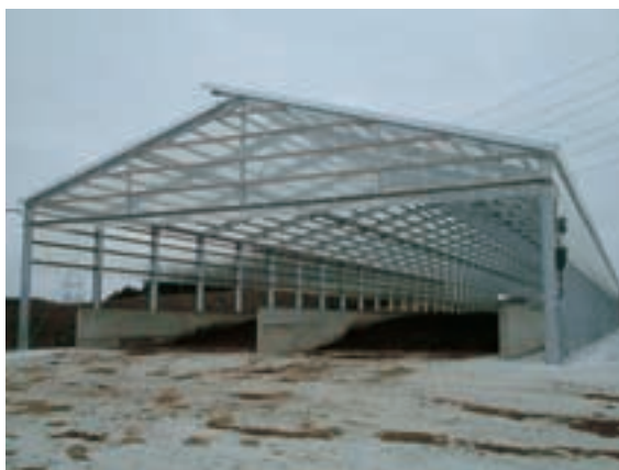
発酵槽投入口
