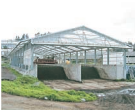
ロータリー式2次処理槽
