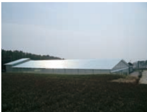
施設全景 (手前：1次処理槽、奥：2次処理槽)
