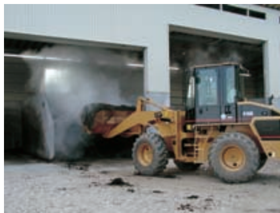
1次処理槽切り返し
