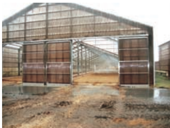
副資材乾燥舎
