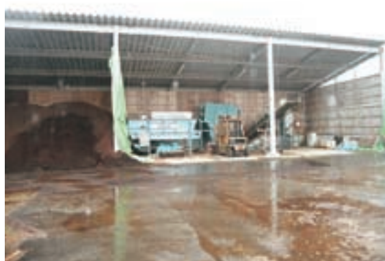
堆肥保管庫・袋詰め舎
