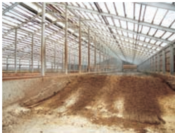
発酵舎：投入側
