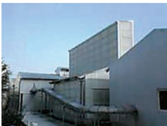
脱臭設備外観
