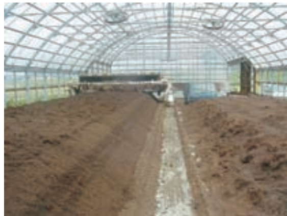
発酵槽仕上側
