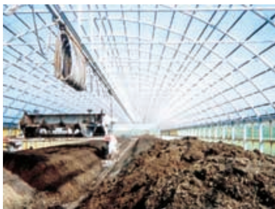
発酵槽投入側
