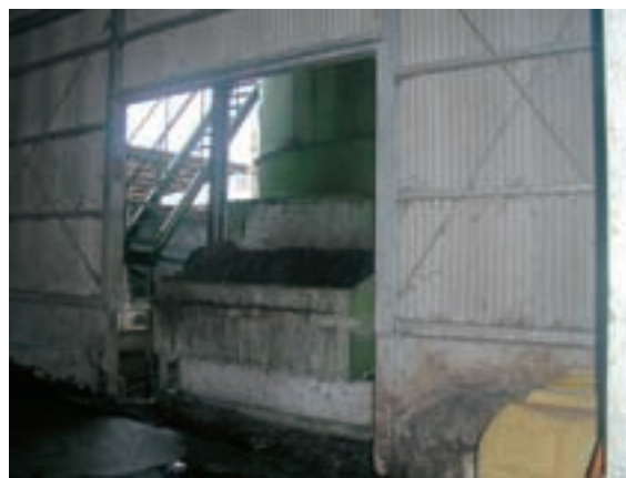
水分調整後投入
