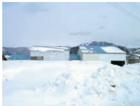
密閉縦型攪拌発酵装置設置建家
